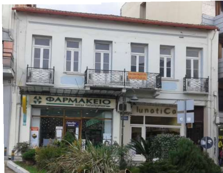
Εικ. 10. Σημερινή όψη κτιρίου
