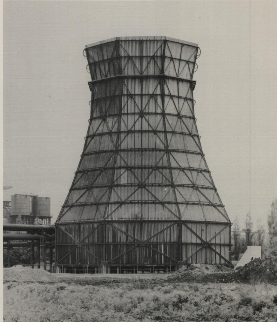
Cooling Tower, Westfalenhütte, Dortmund, Ruhrdistrict
