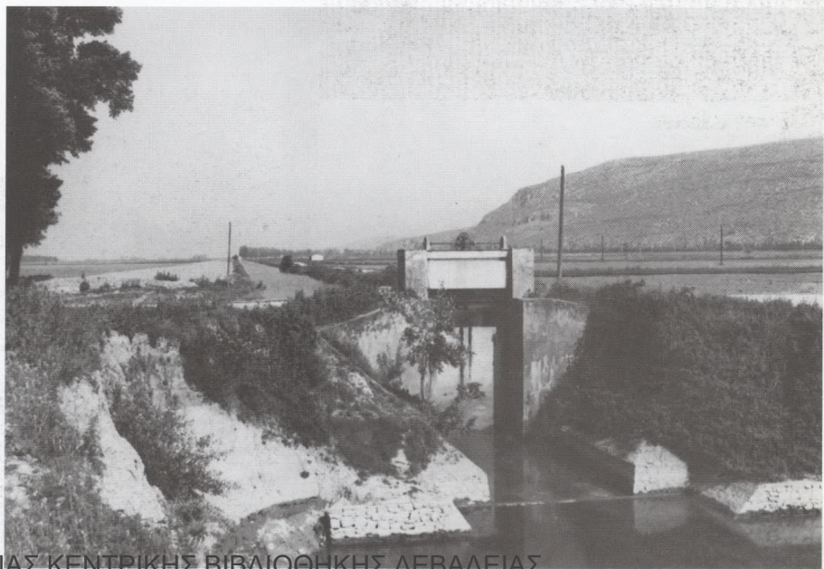
29. Τοπικός διακλαδωτής καναλιού κατασκευασμένος το μεσοπόλεμο
