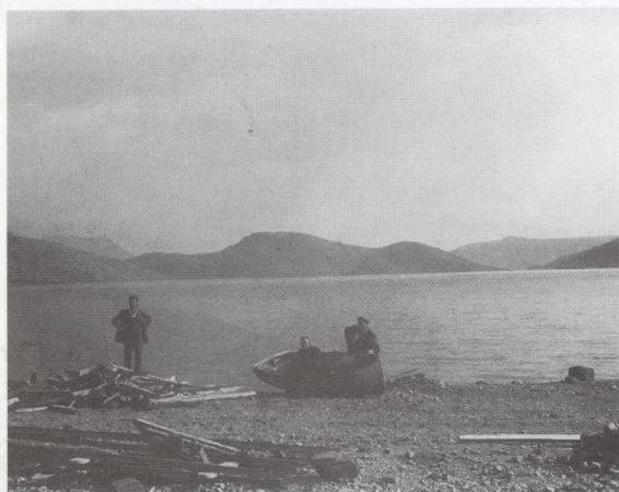
21. Εργασίες στη βορειοανατολική πλευρά της Υλίκης
