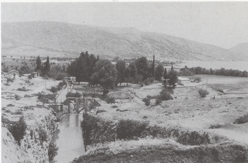
20. Φράγμα ηλεκτροπαραγωγής στην Καρδίτσα (Η κατασκευή του ολοκληρώθηκε το μεσοπόλεμο)
