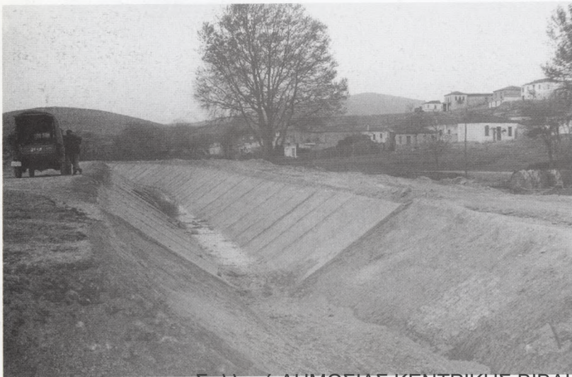
16. Διώρυγα με τσιμεντοποιημένα τα πλευρικά της τοιχώματα
