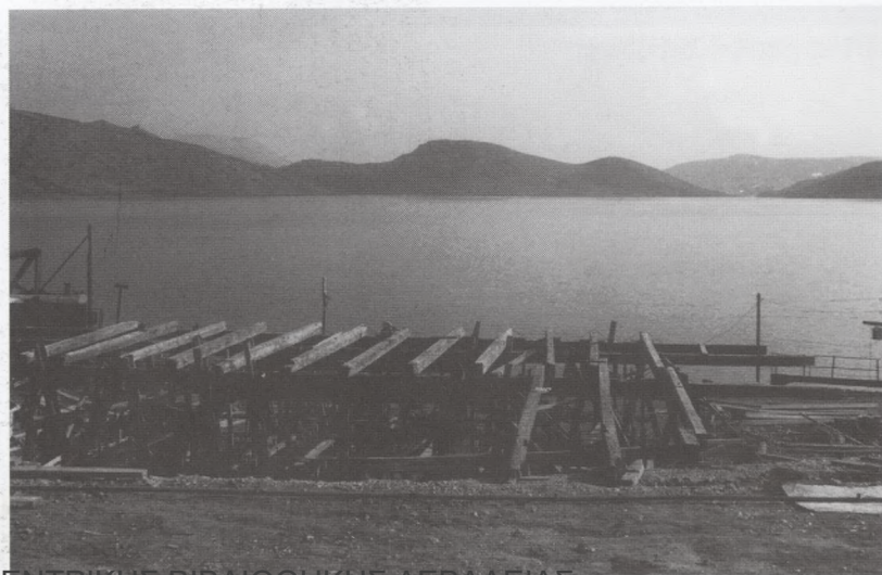
22. Έργα κατασκευής δικτύου μεταφοράς ηλεκτρικού ρεύματος στην περιοχή της Υλίκης
