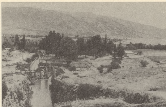
Φράγμα ηλεκτροπαραγωγής στην Καρδίτσα (Η κατασκευή του ολοκληρώθηκε το μεσοπόλεμο)
