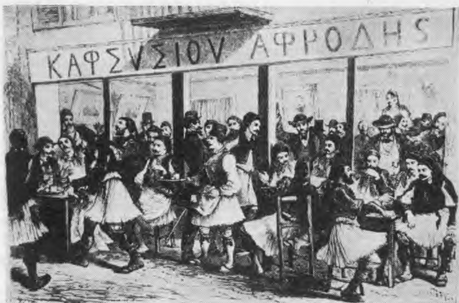
Καφενεῖον ἢ «Ἀφροδίτη»
