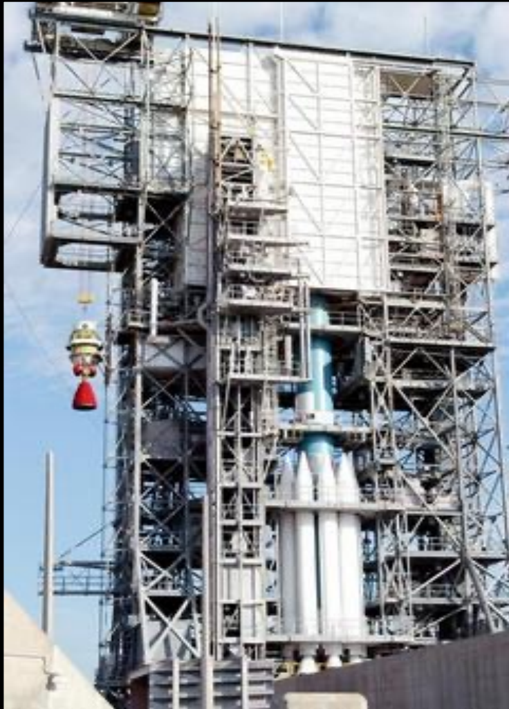
Ο δεύτερος όροφος του Delta ανυψώνεται στον κινητό βοηθητικό πύργο (6 Ιουλίου 2004)
